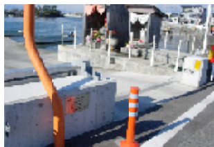
扉がついた ケーズデンキ前の防潮堤
