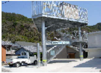
旧日和佐町の津波避難タワー
