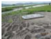
伏流水の取水口
