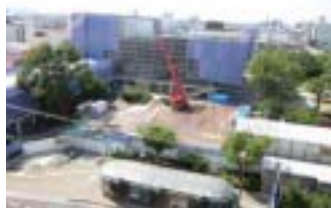
耐震リニューアル中の米子市ホール
